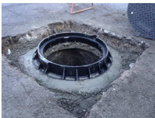
Première couche de pose
