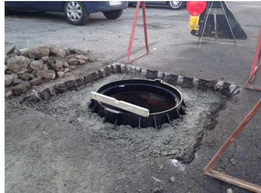
Nivellement du cadre en hauteur
