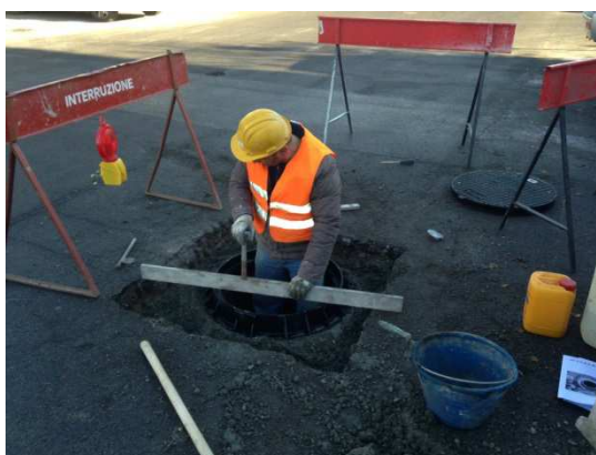
Vérification de la coplanarité avec la couche de roulement
