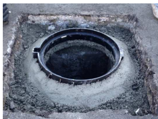
Deuxième couche de pose
