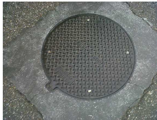
Asphaltage de la zone concernée par la plaque d'égout
