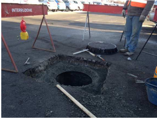
Nettoyage de la zone concernée
